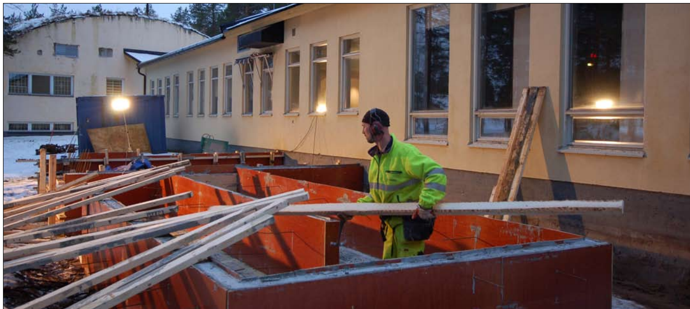
Mats Eriksson, Nåjden, bygger ny entré till filmsalen.
